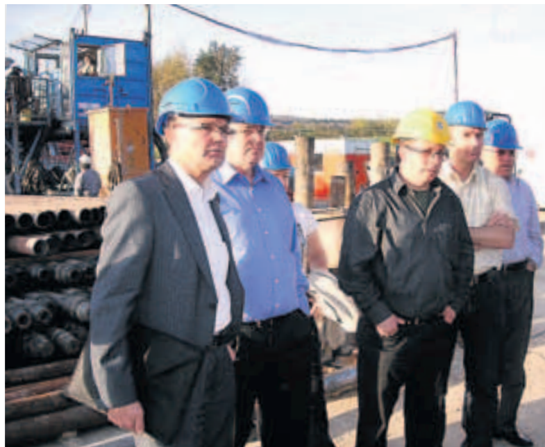
Kaspar Schläpfer (im Bild mit Kantonsrat Richard Nägeli und weiteren Mitgliedern der FDP Bezirk Frauenfeld) bei der Besichtigung der Geothermiebohrung in Schlatt.
