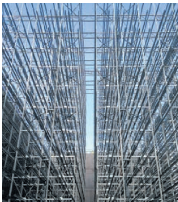
Das Hochregallager nimmt Formen an.
